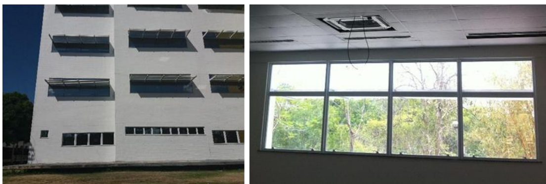
Figura 46. Foto externa e interna das esquadrias da edificação.
