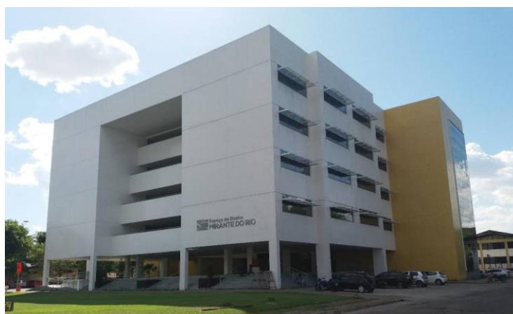
Figura 39. Foto da edificação inserida no entorno do terreno.
