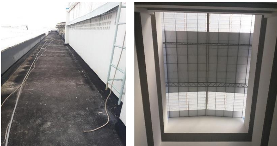
Figura 45. Laje maciça impermeabilizada e cobertura translúcida do átrio central.
